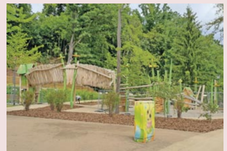
Zum Hingucker sind die vier im Bürgergarten neu installierten Stromkästen geworden. Alle sind entsprechend farbig gestaltet. Im Hintergrund zu sehen ist der neue Erlebnisspielplatz. Foto: Maria Fricke
