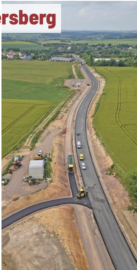
Die Staatsstraße 32 aus Richtung Döbeln kommend mit Blick in Richtung Neudorf. Links neben der Straße beginnt die Asphaltierung des neuen, straßenbegleitenden Radweges. Die Straße an sich ist auf sieben Meter verbreitert worden. Ab September 2025 soll der Verkehr auf dem 1,2 Kilometer langen Abschnitt wieder rollen. Foto: LKW
